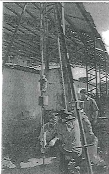
Execução da sondagem 2 - amostra predominante no local ( Areia com gnaisse)
