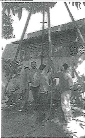
Execução da sondagem 1 - amostra predominante no local ( Areia com gnaisse)
